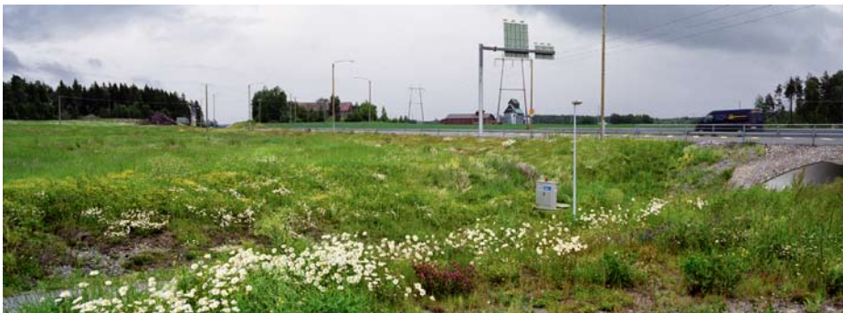
Kuva 2. Halikon maisema-alueen läpi rakennettiin moottoritie. Kuvasarjassa näkyvät uuden liittymätien rakentamisen maisemavaikutukset. (Yläkuva: Oiva Hakala/ Visuaalinen maisemaseuranta, 17.7.2000; keskikuva: Oiva Hakala/ Visuaalinen maisemaseuranta, 6.5.2002; alakuva: Martina Motzbäuchel/ Visuaalinen maisemaseuranta, 30.6.2005)
