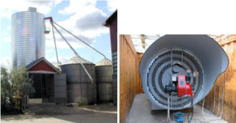
Kuva 4. Alipaineinen kuumailmakuivaamo viljasiiloineen (vasemmalla) ja uuneineen (oikealla). Uunihuoneessa ei ole ilmapuhaltimia, vaan kuivausilma imetään uunin ja kuivurin läpi poistupuolella sijaitsevilla keskipakopuhaltimilla. (Kuvat: Timo Lötjönen)
