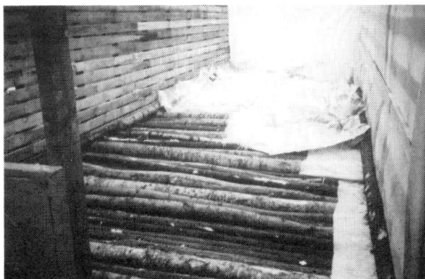
Hakekuivurin rakenne sisältä. Lautaseinä osoittautui välttäväksi. Neliömäinen imukanava sijoitettiin alas ja keskelle kuivuria.
