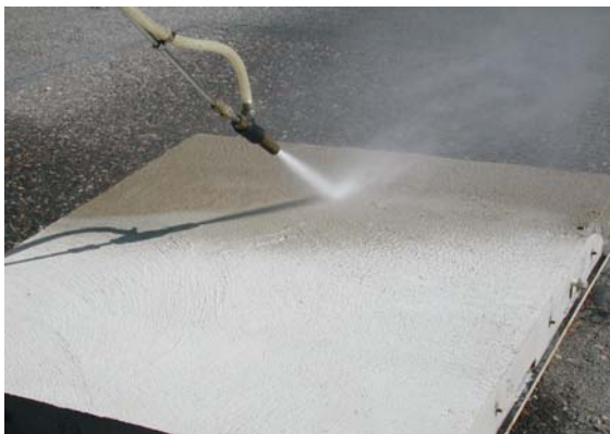
c) betonipinnan vesihiekkapuhallus
