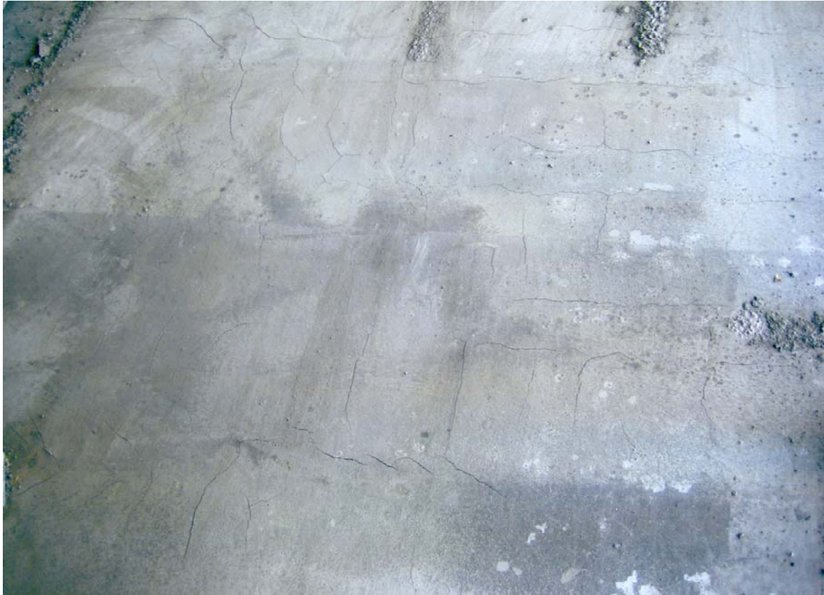
Kuva 5. Epäonnistunut varhaisjälkihoito aiheuttaa lattiapintaan pysyviä vaurioita. Kuvan lattia valettiin hyvälaatuisella betonilla kesällä. Tuoreen, notkean/plastisen betonilattian pinta on tuulisuuden ja auringonpaisteen vuoksi päässyt kuivumaan liikaa, joten tuoreen/plastisen betonin pintaan on syntynyt ruutu/verkkomaista kutistumishalkeilua. (Kuvassa esitettyjen halkeamien väliset etäisyydet vaihtelevat pääsääntöisesti välillä 10 - 20 cm. Yläreunassa näkyy yksittäisiä noin 16 mm:n suuruisia runkoainerakeita). Kuvankaltaisten halkeamien estämistoimenpideohjeet on esitetty tekstissä. Kuva Juha Komonen.
