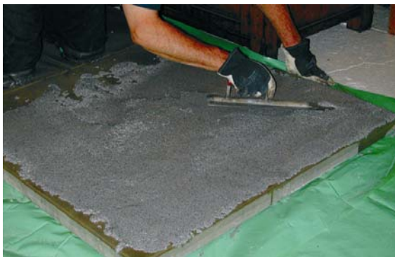
e) hieptoepoksinpinnoitteen levitys lastalla
