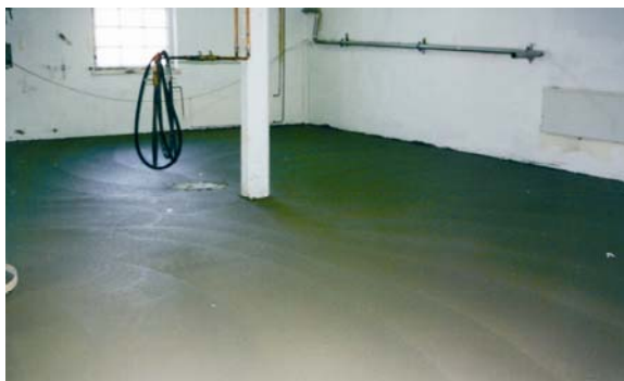
g) hierretty valmis betonipinta
