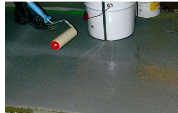
f) epoksinpinnoitteen pintalakkaus
