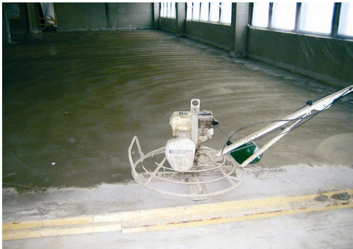
Kuva 2. Hyvälaatuinen betoni on onnistuneen lattian perusta. Kuva Juha Komonen.
