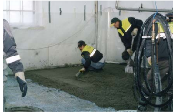
b) lattiamassan levitys alumiinilinjarilla
