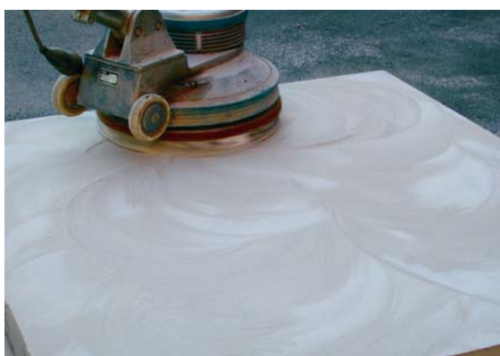
e) betonipinnan konehionta
