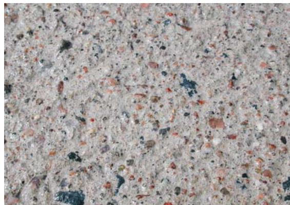
d) vesihiekkapuhallettu betonipinta
