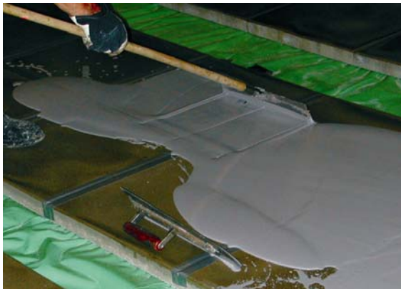
c) siliävän pinnoitteen levitys säätölastalla
