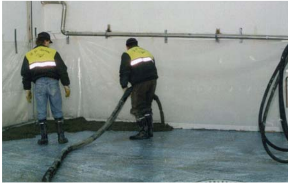
a) lattiabetonin siirto pumpulla
