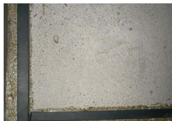
f) kone- / käsihiottu betonipinta
