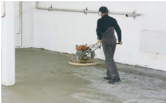
e) betonipinnan konehierto
