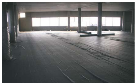
h) jälkihoito kastellulla suodatinkankaalla
