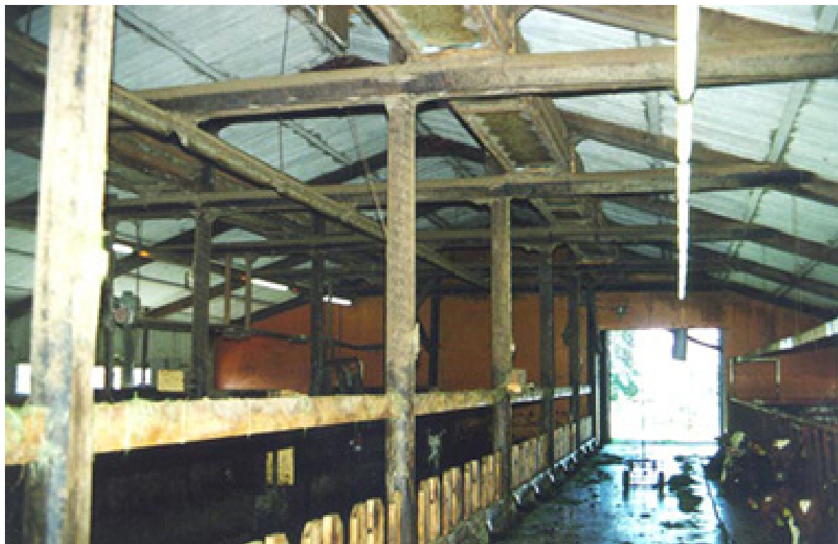
Kuva 17. Sisäkuva pihatosta 4, katon yläosassa näkyvät tuloilman jakokanavat.
