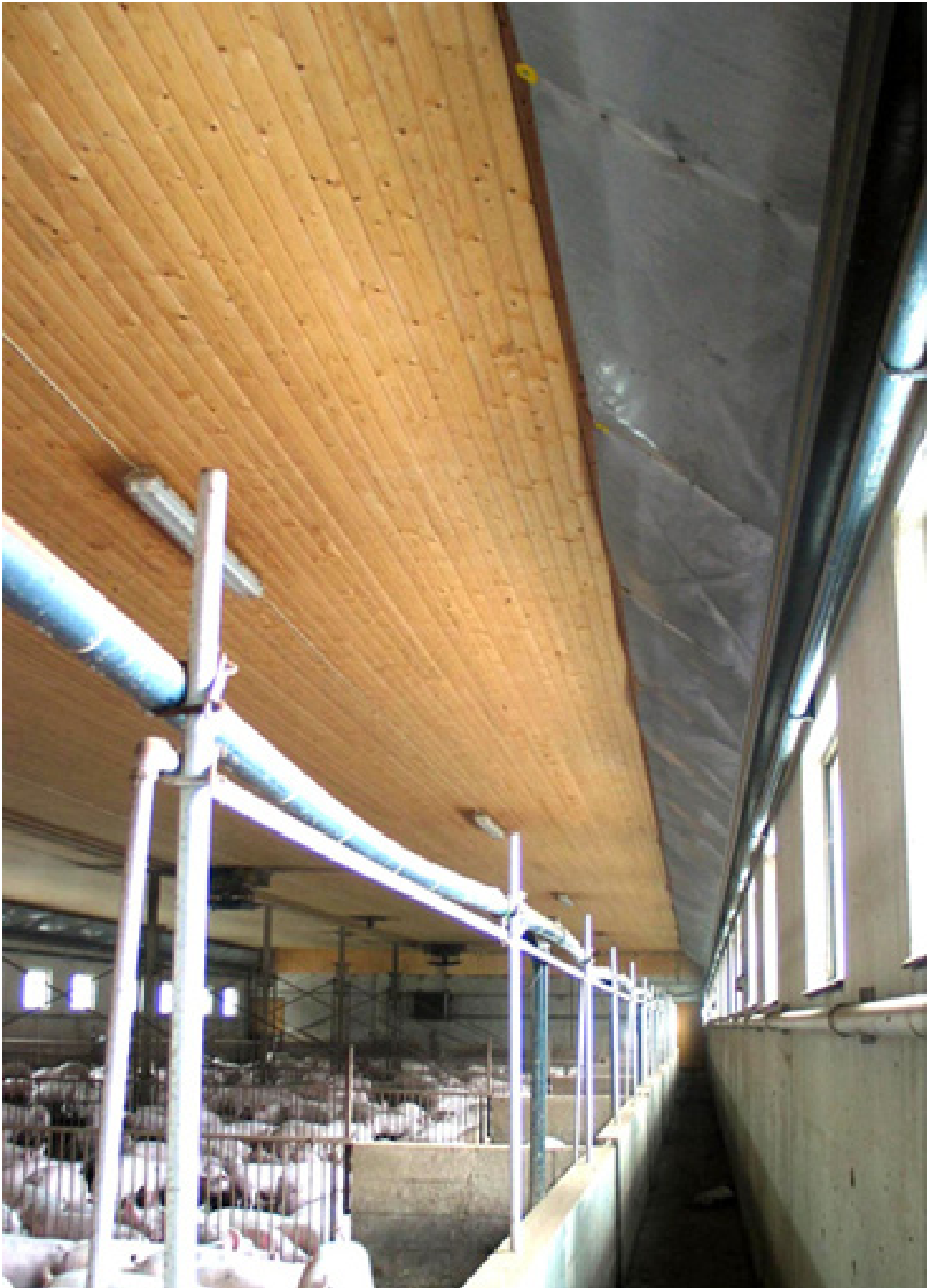
Kuva 34. Lihaskala 8:n sisäkuva. Seinän ja katon liittymäkohdassa on itkupintatuloilmalaite. Katto- paneloinnin pinta on puhdas ja virheetön.
