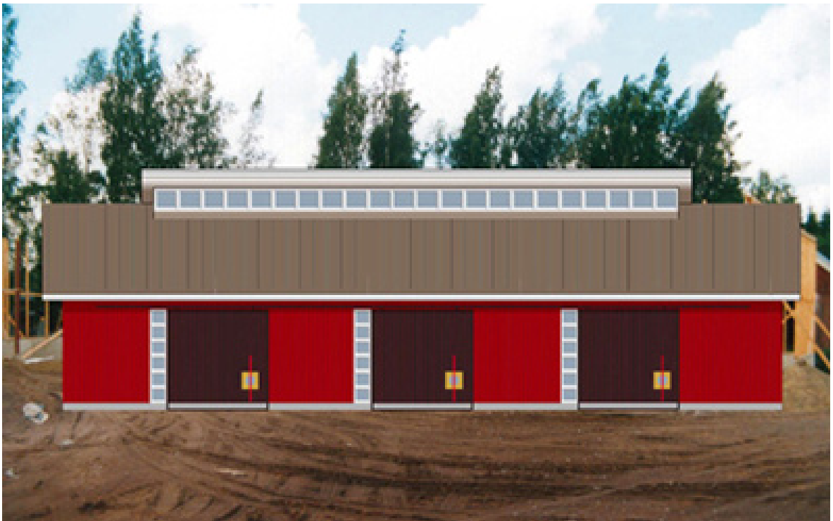
Kuva 52. NR-kehät tai postframe-runko ei rajoita konehallin julkisivusuunnittelua vaan antaa runsaat mahdollisuudet vapaaseen ovisijoitteluun ja ikkuna-aukotukseen.
