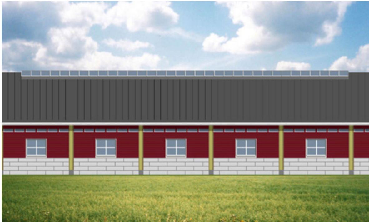
Kuva 71. Sikala tai lypsykarjapihatto toteutettuna pilarihallina, jossa kantava rakenne on jätetty eristetyn ulkoseinärakenteen ulkopuolelle. Seinärakenteen alaosa on muurattu eristetyistä harkoista ikkunakorkeuteen ja yläosa on puurakennetta.
