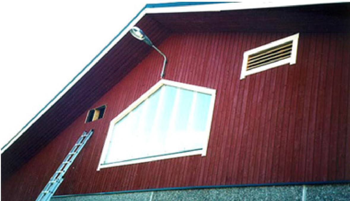
Kuva 27. Pihatto 6:n ullakko-ontelon tuulettuvuutta on parannettu päätyihin tehdyillä säleikoilla, joiden kautta ilma pääsee liikkumaan rakennuksen pituussuunnassa.
