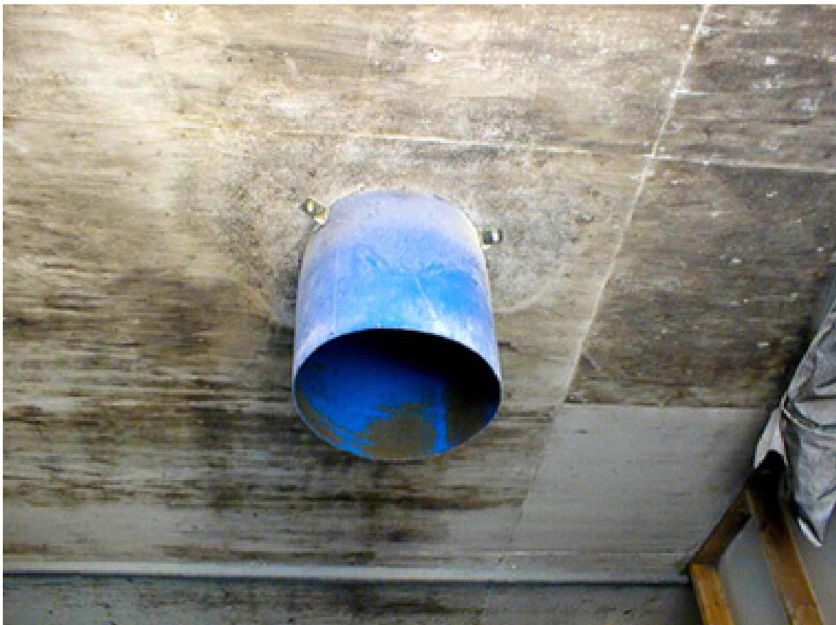
Kuva 22. Sisäkuva pihaton 5 rehunpurkutilasta. Maalattu vanerikatto on homepilkuston peittämä.
