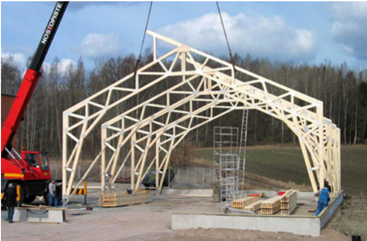
Kuva 47. NR-kehien asennusta konehallityömaalla. Katon toisiokannattajat voidaan tehdä sahatavarasta, jos kehäväli eli ylitä 4 m. Tässä kohteessa kehäväli on 5 m, ja toisiokannattajina käytetään uudentyyppisiä puurakenteisia PI-palkkeja. Palkit valmistetaan normaalista sahatavarasta puristamalla ylä- ja alalaipat naulalevynauhan välityksellä uumalankkuun. Kuvassa PI-palkit ovat nipussa hallin keskiosassa.
