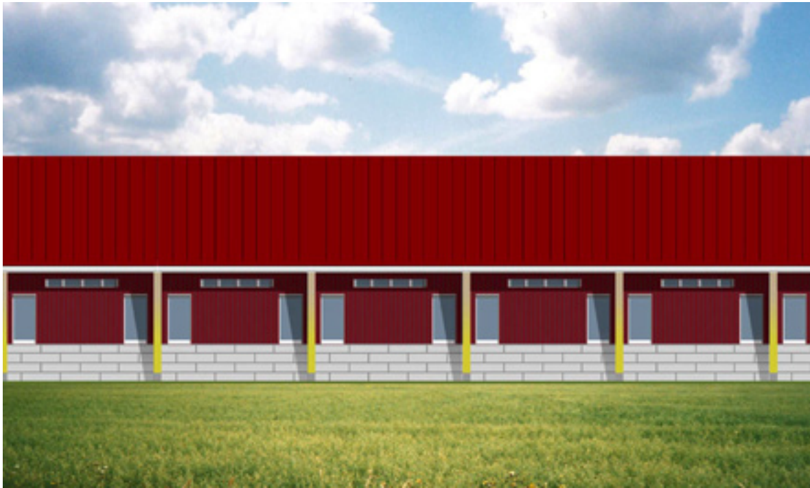
Kuva 73. Sikala tai lypsykarjapihatto toteutettuna kolminivelkehillä, joiden pystyrakenne on eristetyin seinälinjan ulkopuolella. Rakenne luo julkisivuun voimakkaan sommitteluaiheen, joka jäsentää seinäpintaa ja samalla pienentää rakennuksen mittakaavallista kokoa.
