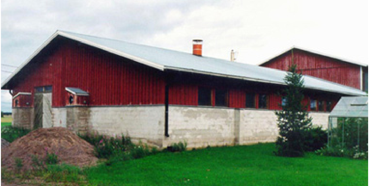
Kuva 8. Ulkokuva pihatosta 2. Alapoiston ulkokanavat ja imurit näkyvät rakennuksen päädyssä. Kesäilmanvaihdon poistokanava on katon harjalla.
