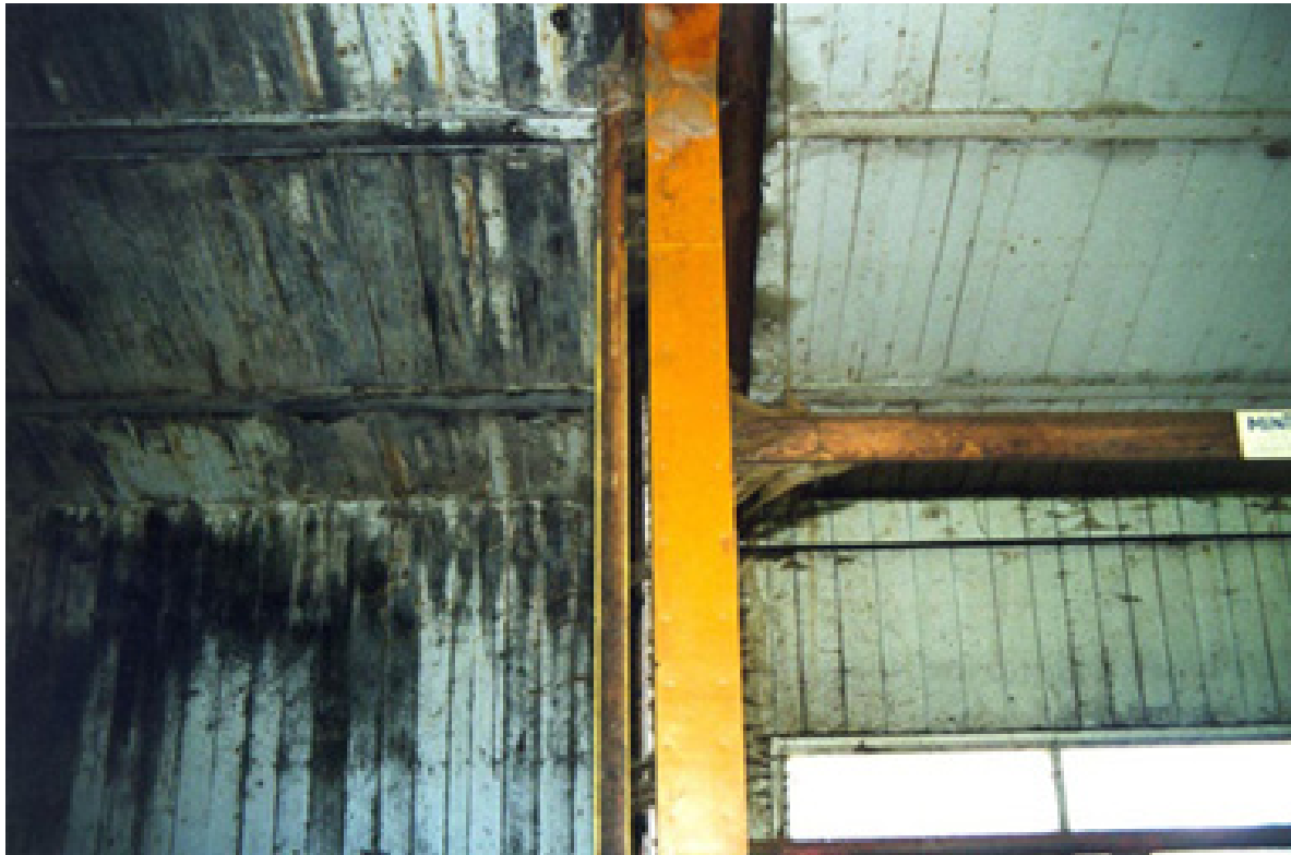
Kuva 16. Sisäkuva pihatosta 4. Keskellä eläintilaa ja rehutilaa jakava seinä. Oikealla eläintilan lautoitettujen seinät ja katto ovat lähinnä pölyisiä, mutta eivät homeessa. Vasemmalla rehutilan vastaavat pinnat ovat tumman homepilkkuston peitossa. Syynä tähän on lämpökuorman (eläinten) puuttuminen tilasta. Samalla ilman kierto ja vaihtuminen rehutilassa on puutteellinen.
