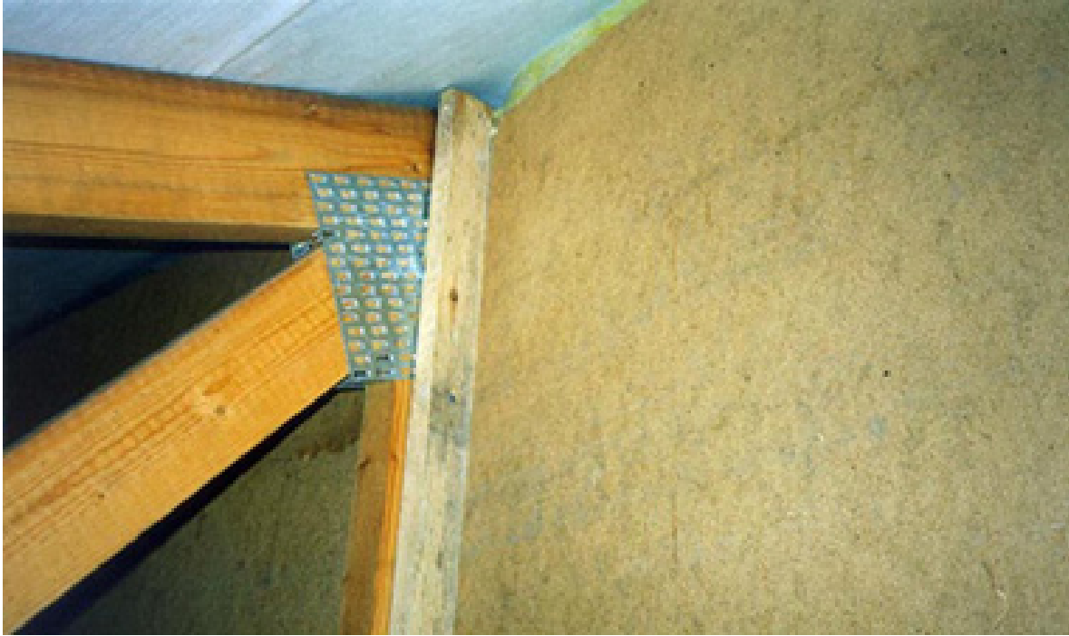
Kuva 26. Pihatto 6:n vesikaton ristikkotilan tuulettuminen harjalle on estynyt, koska kuvassa oikealla oleva eristeen suojana oleva tuulensuojalevy liittyy suoraan vesikaton aluskatteeseen. Katso myös leikkausta kuvassa nro 23.
