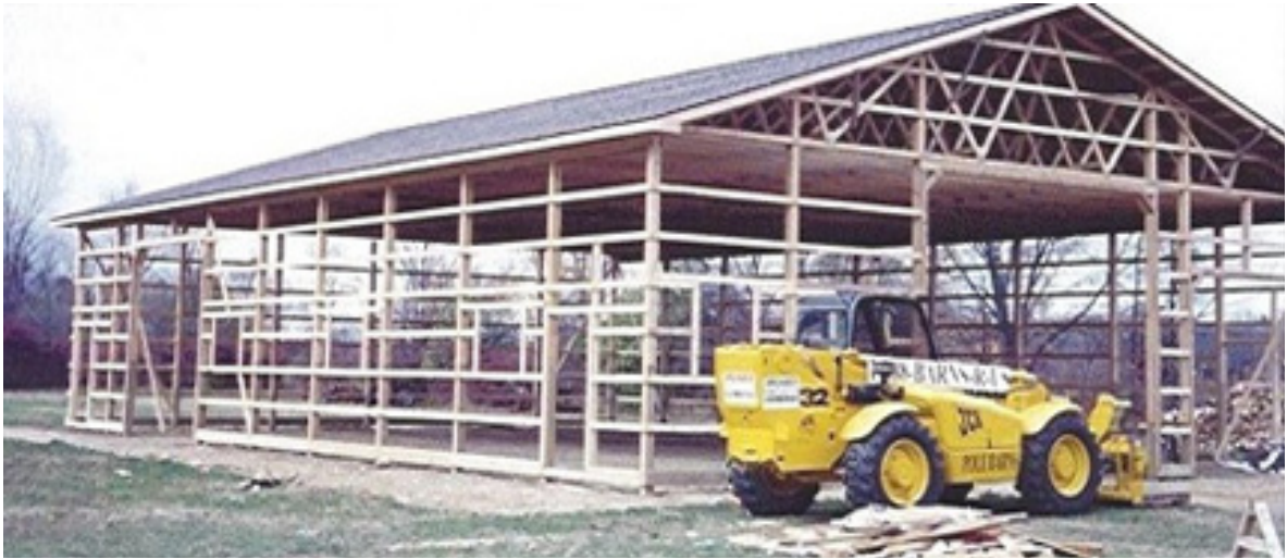
Kuva 51. Postframe-halli rakenteilla
