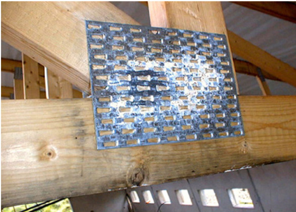
Kuva 39. Naulalevyssä olevaa valkoruostetta jo työmaavaiheessa pihatossa nro 6.
