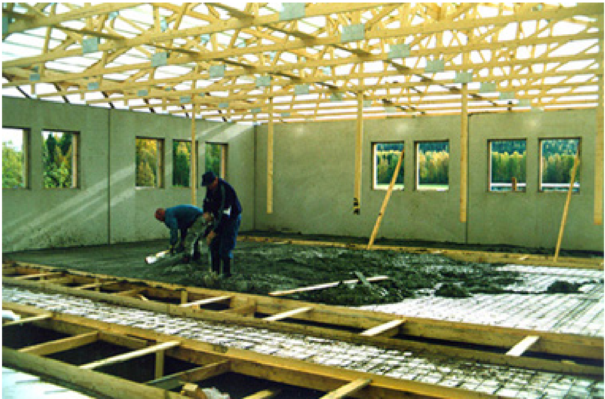
Kuva 1. Tyypillinen sikalatyömaa, jossa kantavat seinät ovat betonielementtejä ja kattorakenne naulalevyristikkoa.
