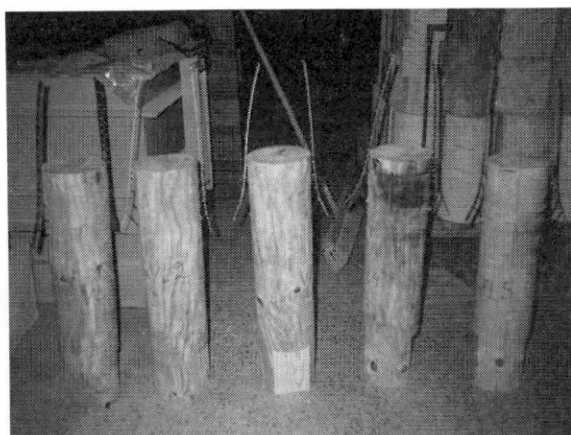
Kuva 18. Vedossa rikkoutuneita reikävanneliitoksia.
