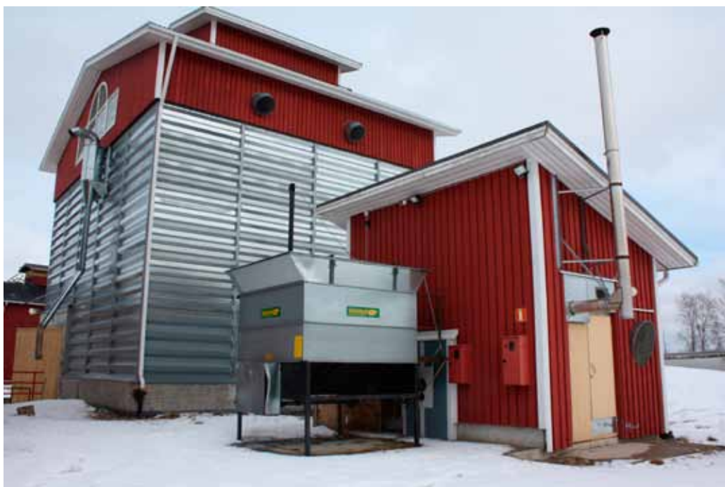
Kuva 2. Esimerkki kuivuriin kiinteästi asennetusta kiinteän polttoaineen lämmitysjärjestelmästä. Lämpöteho on 400 kW. Kuva: Petri Piipari
